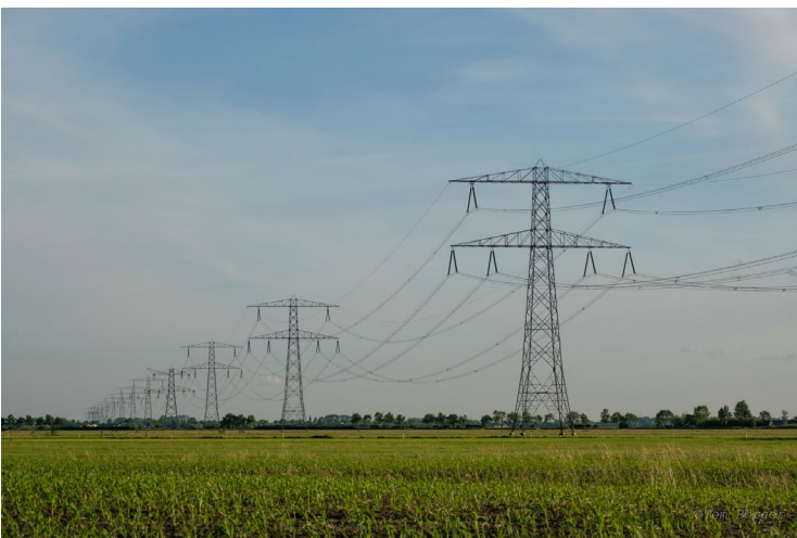
Figuur 2-4 | Bestaande verbinding Breukelen – Diemen (380kV links, 150kV rechts)
